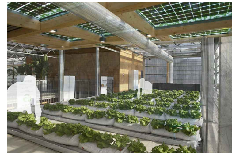
CUBIERTA INVERNADERO + SOBRE EDIFICIO INDUSTRIAL
