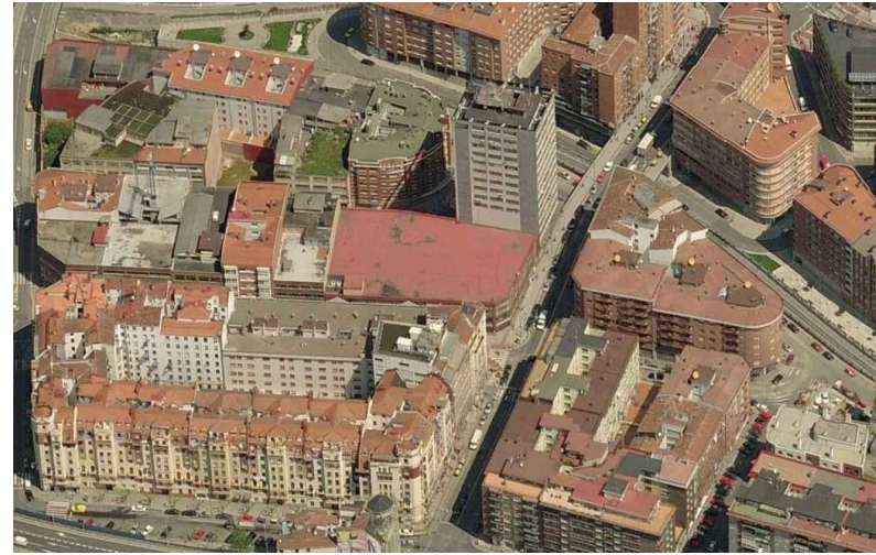
CALLE GORDONIZ + EDIFICIO INNOLAB BILBAO
