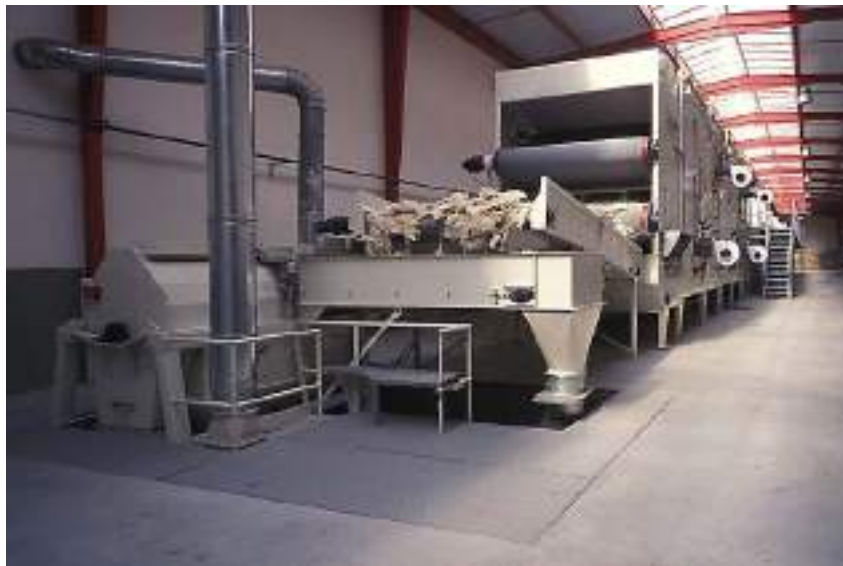
Texte 3: lavage Manuel Rodrigues Tavares (STMRT) - Colonne Andar et sa station de traitement des eaux acquise neuve et en exploitation depuis 2002 - vidéo
